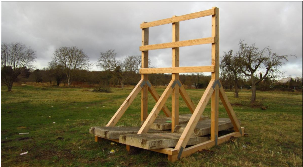
Abb. 1: Baugerüst (Quelle: eigene Aufnahme)
